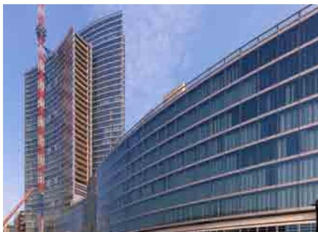
con fattore solare 32%, trasmittanza termica  $U=1.1$  W/mqK e distanziatori in acciaio inox in grado di ridurre notevolmente le dispersioni lineari lungo il perimetro del vetro.
