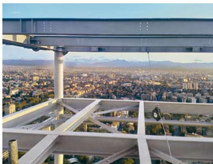
Alto 20 metri , quasi 5 piani, il velario è coperto da un grigliato pedonale dove corrono le macchine per la pulizia delle facciate.
