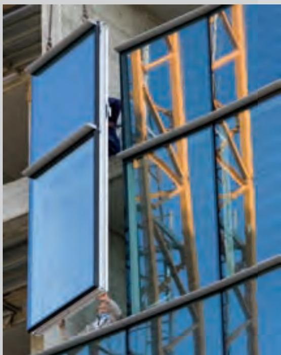
Allineamento e innesto delle cellule a baionetta sulla facciata già montata. ■
