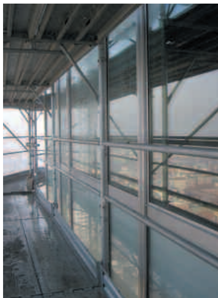
E' in corso la prova di tenuta all'acqua a cura dell'Istedil di Roma. Il 10 % della facciata è stata sottoposto a test in opera secondo le richieste della Direzione Lavori.
